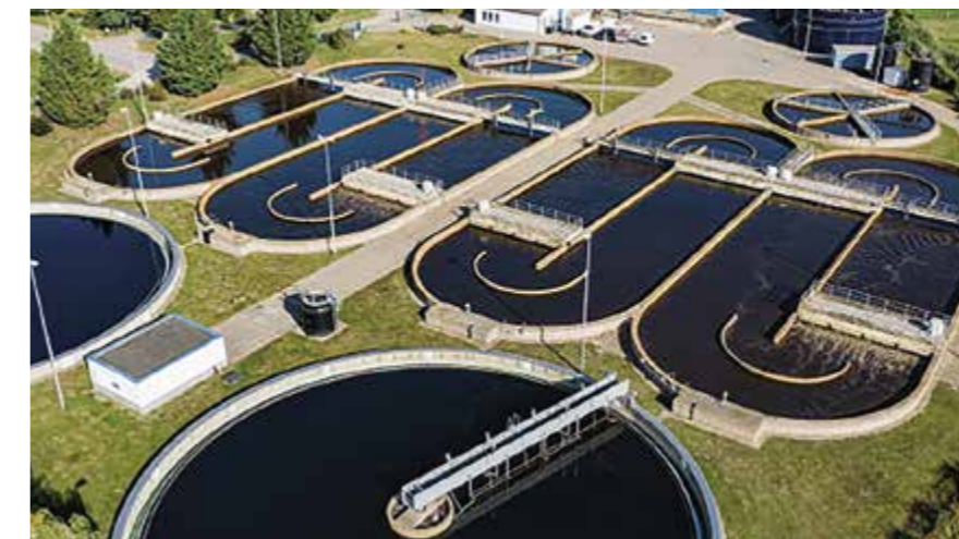
Die MBZ-Technologie wird mit dem Abwasser aus einer Kläranlage betrieben.
